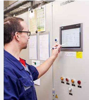
Gestion de la température du local
