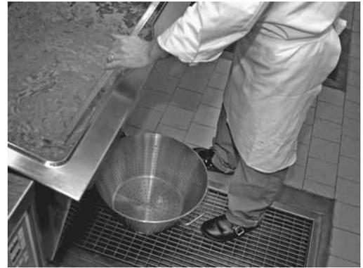
Figure 1: les grilles antidérapantes et au même niveau que le sol évitent les accidents par glissade et les chutes de plain-pied.
