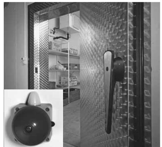
Figure 8: on doit toujours pouvoir entendre l'alarme du local frigorifique
