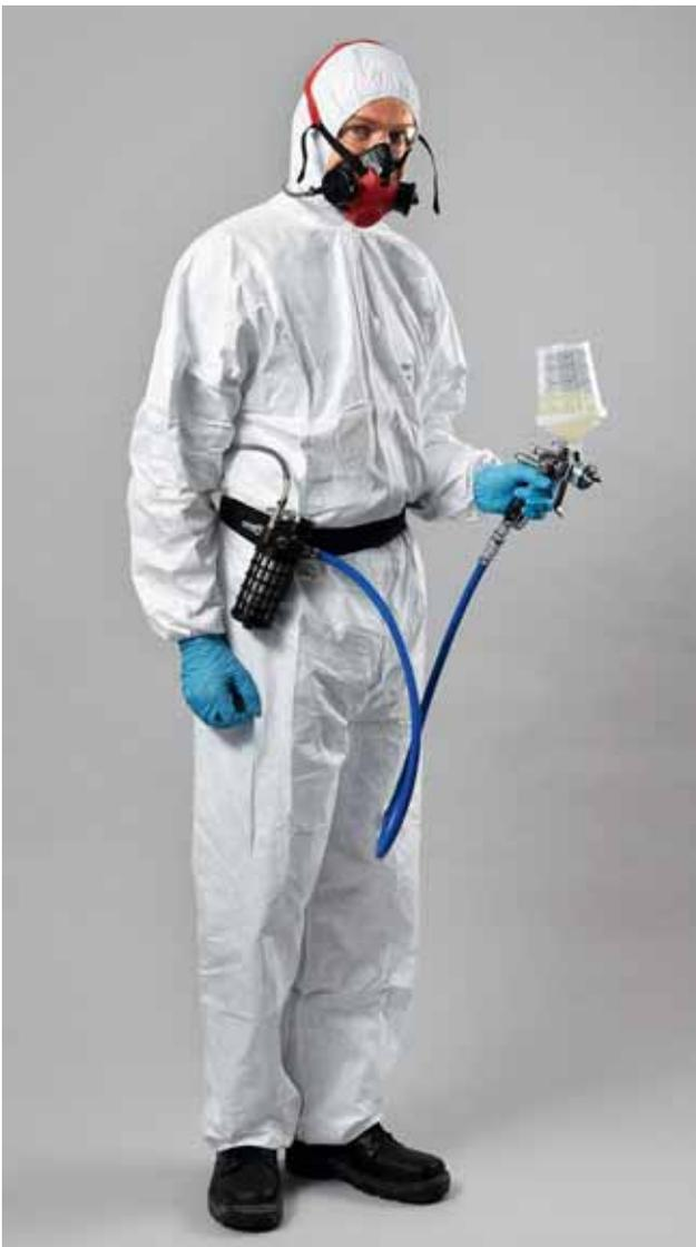
**Bild 9:** Vollständige PSA: Druckluft-Schlauchgerät nach SN EN 14594 der Klasse 3 mit Halbmaske, Schutzbrille, Chemikalienschutzanzug (Typ 5) und Handschuhen. Der Druckluftschlauch wird am Gürtel angeschlossen und versorgt die Halbmaske und die Spritzpistole mit Luft.
