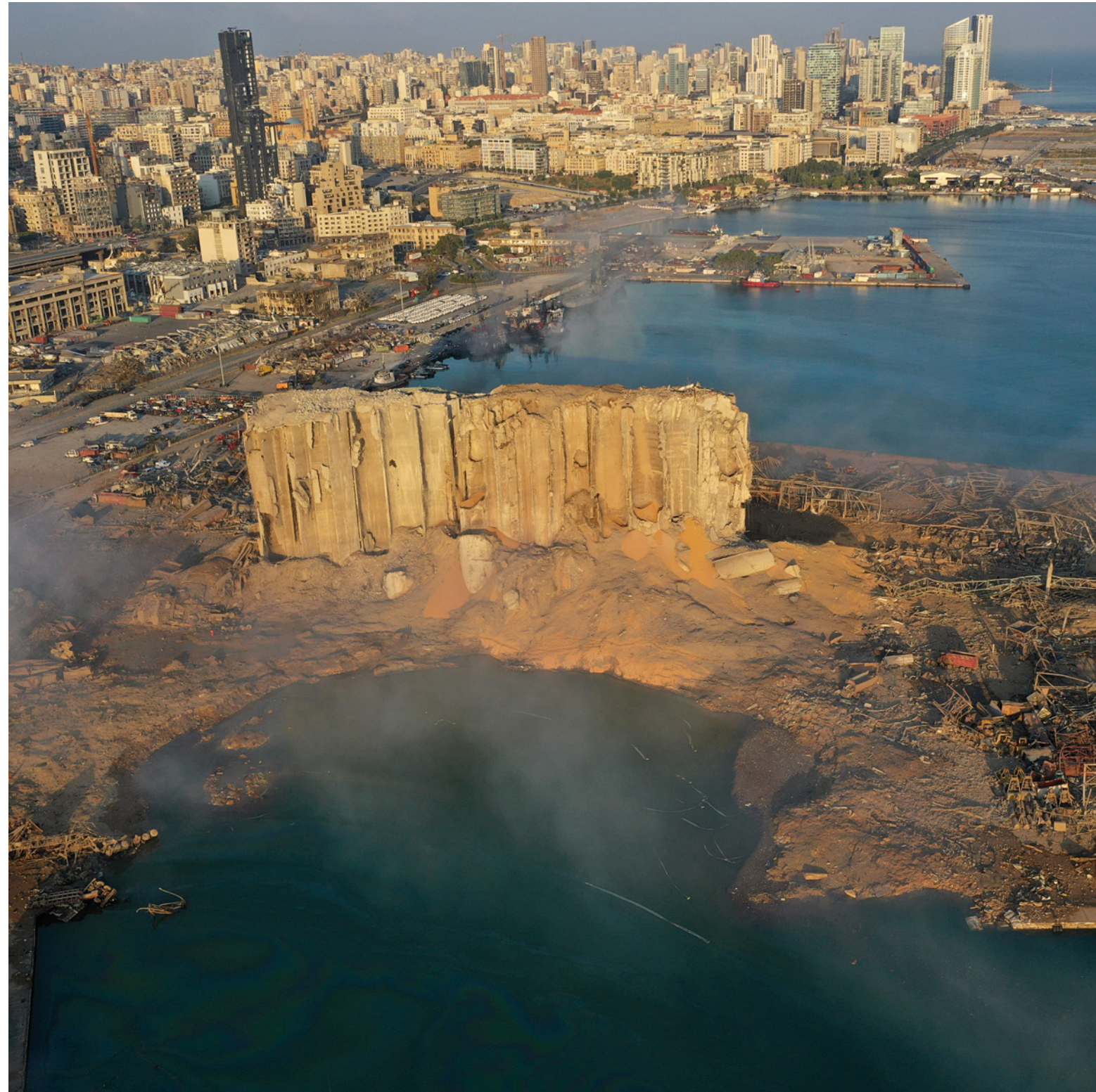
Zerstörungen im Hafen von Beirut nach der Explosion am 4.8.2020
