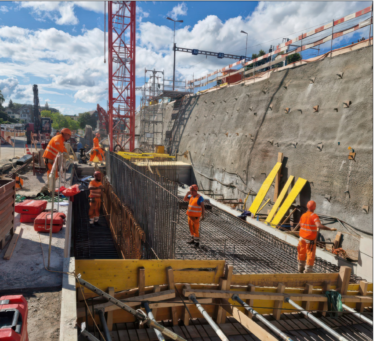
Fundament der Stützmauer für die neuen Perrons der Haltestelle Europaplatz Nord / Bild: SBB
