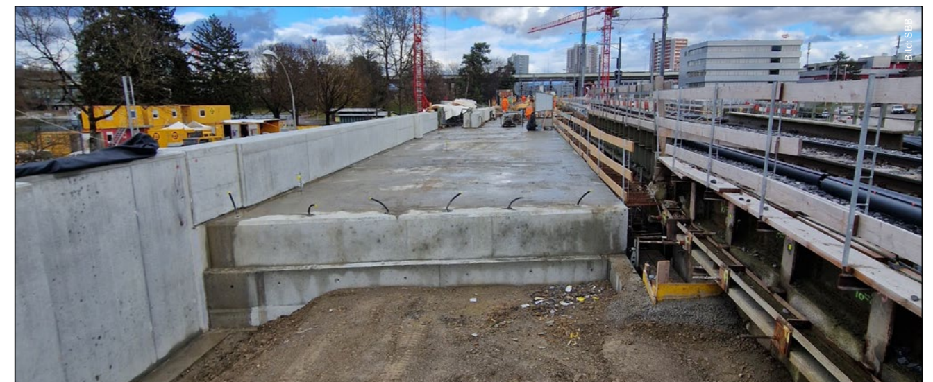
Die neue Decke der Unterführung Stöckacker auf der Nordseite ist fertig betoniert.
