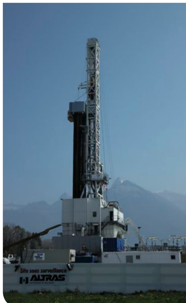
Forage de prospection d'hydrocarbures à Noville (VD).
